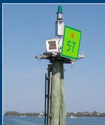
Estación permanente de monitoreo de calidad del agua
